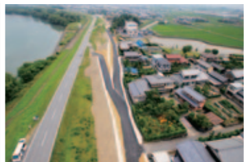
築堤護岸等の堤防補強(一部完成)
