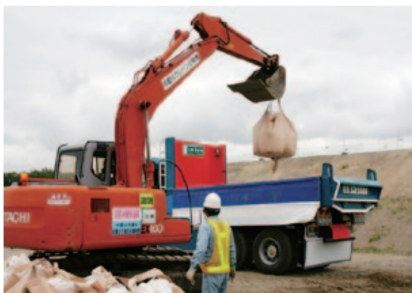
防災ステーションでの資材の積み込み
