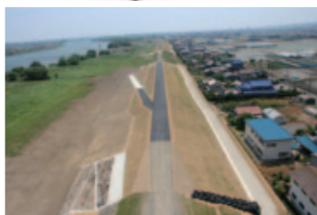
築堤護岸等の堤防補強(完成)
