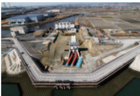
①城南排水機樋管の改築
