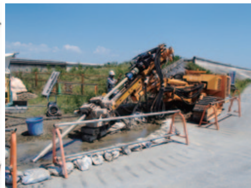
②加路戸排水機樋管部の堤防補強工事
