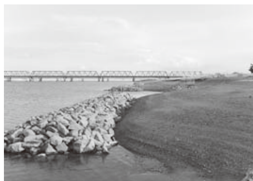
完成した現場写真
