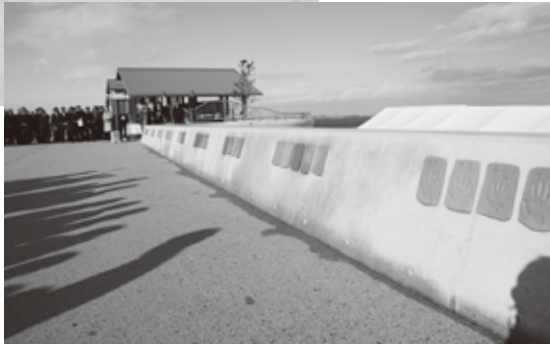
堤防に貼り付けられた手形のレリーフ
