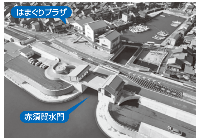
完成後の赤須賀水門と高潮堤防 (平成22年12月撮影)
