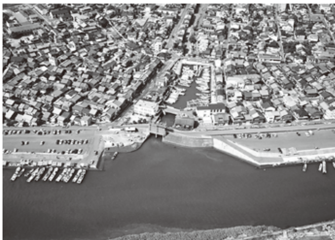
着工前の赤須賀地区 (平成18年3月撮影)
