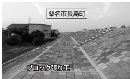
木曾川右岸鎌ヶ地地区（桑名市長島町東殿名地先）の高潮堤防整備は完成に向けて波返し工やブロック張り工を実施しています。
