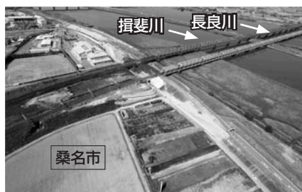
損斐川右岸深谷地区（桑名市下深谷部地先）については一連区間の完成に向けて堤防高上げ工事を実施しています。
