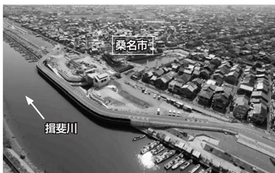
損斐川右岸吉之丸地区（桑名市大字赤須賀地先）の高潮堤防整備は赤須賀地区一連の完成に向けて、赤須賀水門周辺の堤防工事を実施しています。
