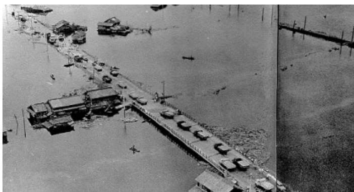
冠水した国道1号(海部郡弥富町)
