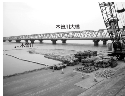
「平成20年度 木曽川 源緑環境整備工事」施工状況 （平成20年11月撮影）
