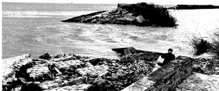
まつかけ 破堤した松陰海岸堤
