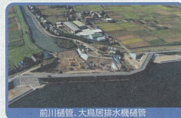
前川樋管、大鳥居排水機樋管
