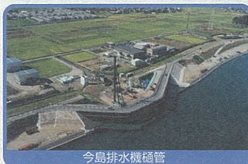
今島排水機樋管
