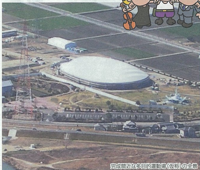
完成間近な多目的運動場(仮称)の全景
