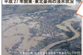
平成27年関東・東北豪雨の浸水状況
