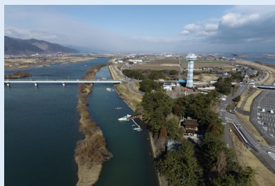
重点的撤去区域の状況(R4.1) 海津市 油島地先
