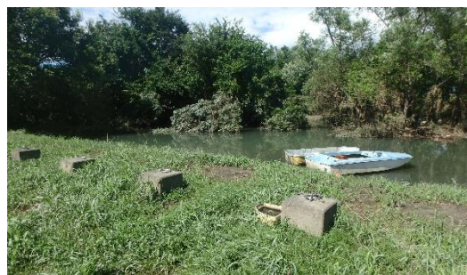
樹林化した変形護岸
