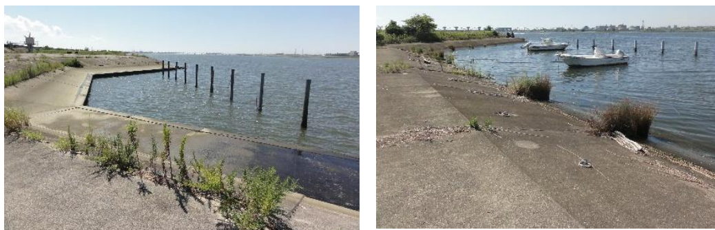
写真3 変形護岸の施設状況
