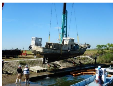
令和 4 年 鍋田上水門
