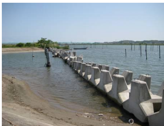
写真 13 変形護岸の締め切り（下坂手）
