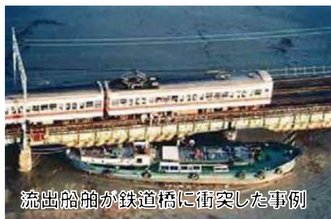
流出船舶が鉄道橋に衝突した事例 出典：国土交通省 武雄河川事務所ホームページ
