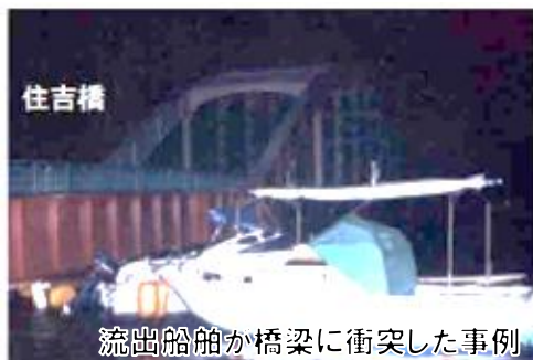
流出船舶が橋梁に衝突した事例 出典：国土交通省 武雄河川事務所ホームページ
