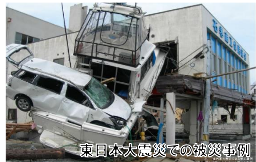
東日本大震災での被災事例 出典：国土交通省 北上川下流河川事務所 提供
