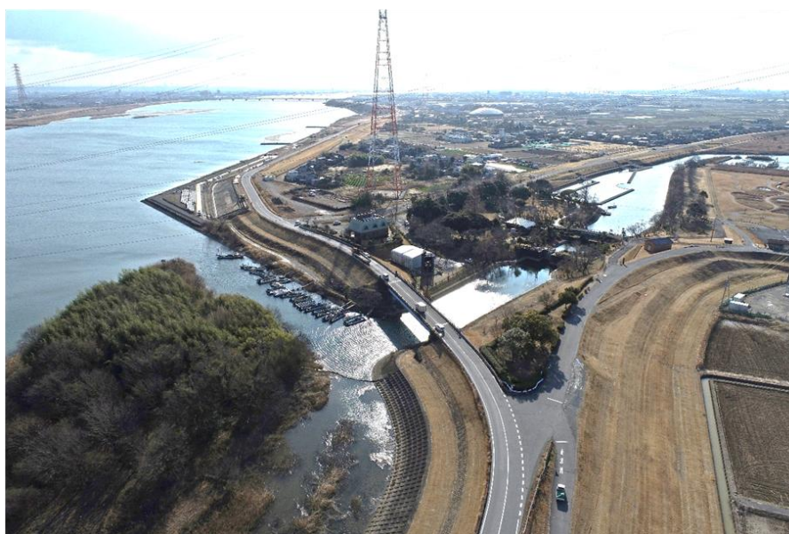
桑名市長島町西川地先から船頭平閘門木曾川水路 (R 4 . 1 撮影)
