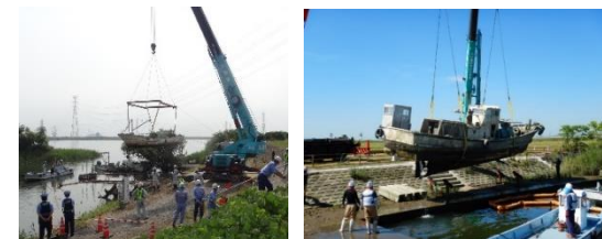
代執行の実施の様子(左:R2 船頭平閘門 右:R4 鍋田川上水門)
