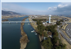
重点的撤去区域の状況(R4.1) 海津市 油島地先
