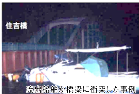
住吉橋 流出船舶が橋梁に衝突した事例 出典：国土交通省 武雄河川事務所ホームページ
