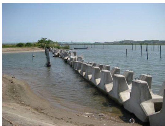
写真 12 変形護岸の締め切り（下坂手）
