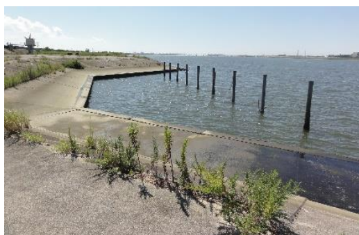
写真3 変形護岸の施設状況
