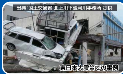
船舶流出による家屋への 二次被害
