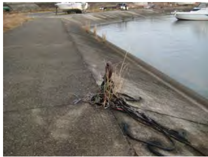
係留杭の設置による護岸損傷
