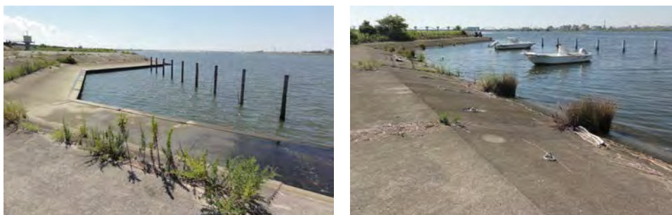
写真3 変形護岸の施設状況
