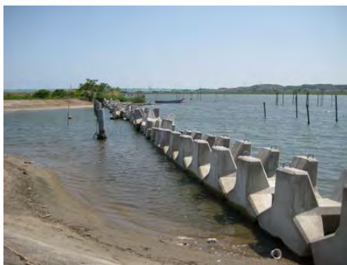
写真 12 変形護岸の締め切り(下坂手)
