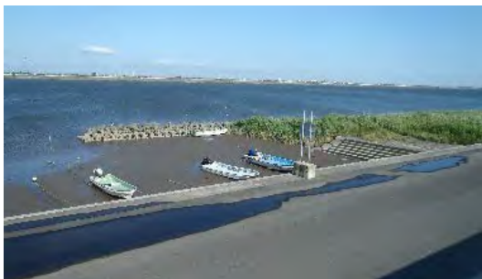
土砂堆積した変形護岸
