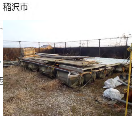
撤去棧橋の保管状況 平成26年2月17日 17時00分保管完了
