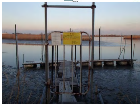
放置棧橋の状況 揖斐川右岸6.6k+160m (桑名市大字上之輪新田地先)
