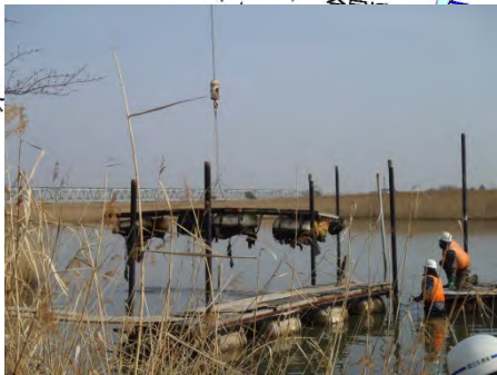
棧橋の撤去作業状況 平成26年2月17日 12時00分解体・撤去完了
