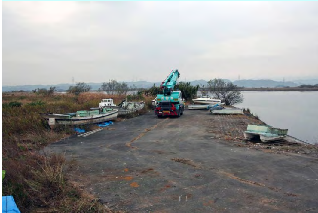
撤去作業前の状況 (H22.12.7 8:30撮影)
