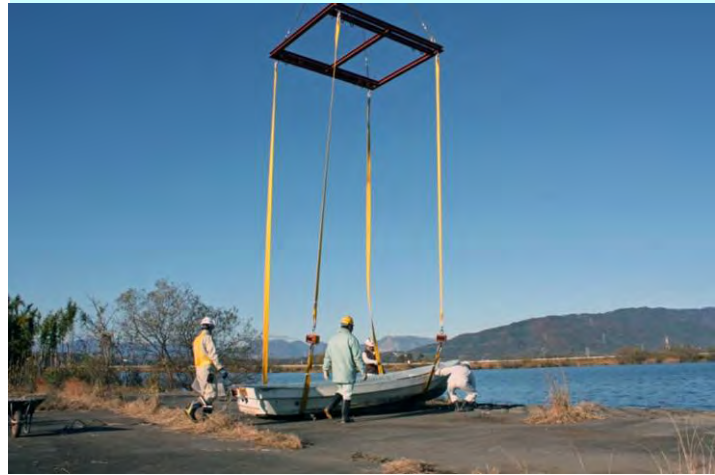
船舶番号17の撤去作業(12/8)
