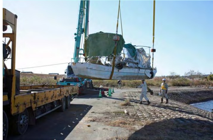
船舶番号5の撤去作業
