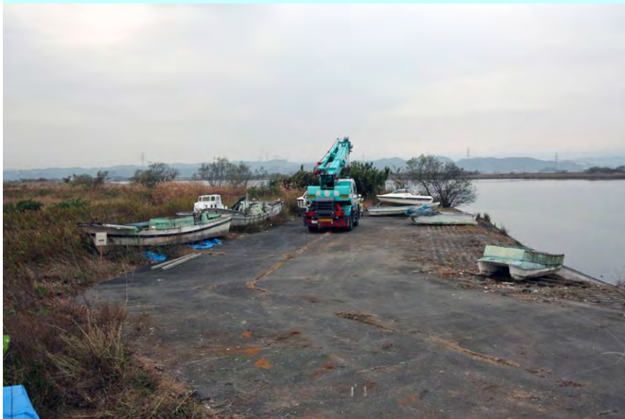
撤去行前の状況 (H22.12.7 8:30撮影)
