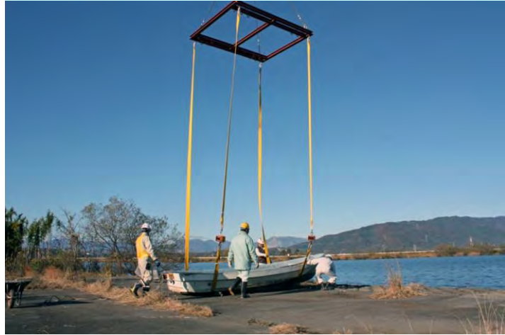
船舶番号17の撤去作業
