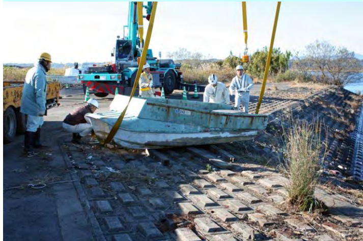
船舶番号9の撤去作業
