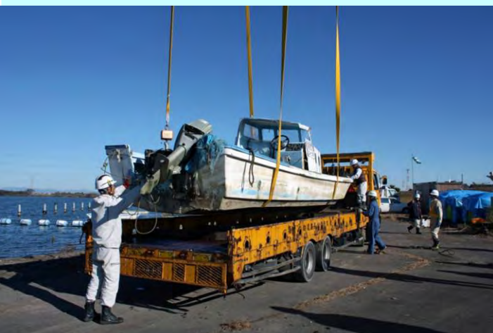
船舶番号18の撤去作業
