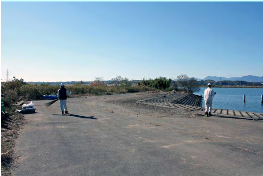
撤去作業完了後の状況 (H22.12.8 11:30撮影)
