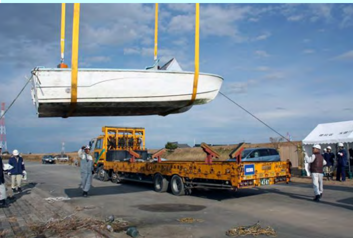
船舶番号2の撤去作業
