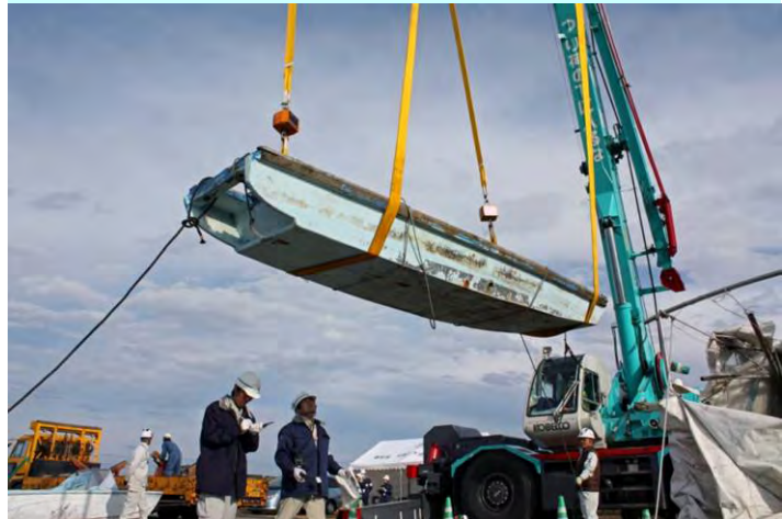
船舶番号4の撤去作業
