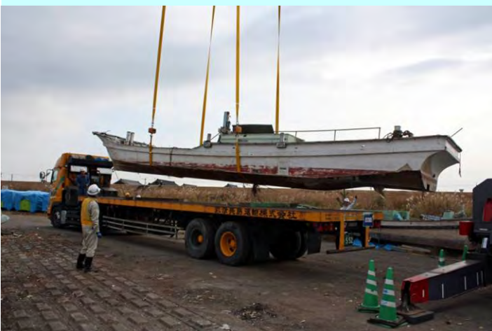
船舶番号12の撤去作業
