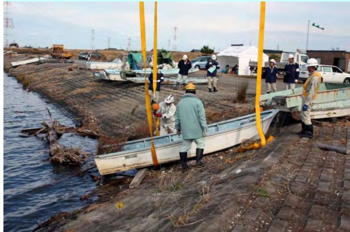
船舶番号11の撤去作業
