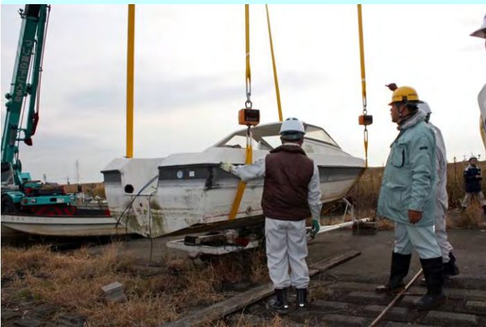
船舶番号19の撤去作業
