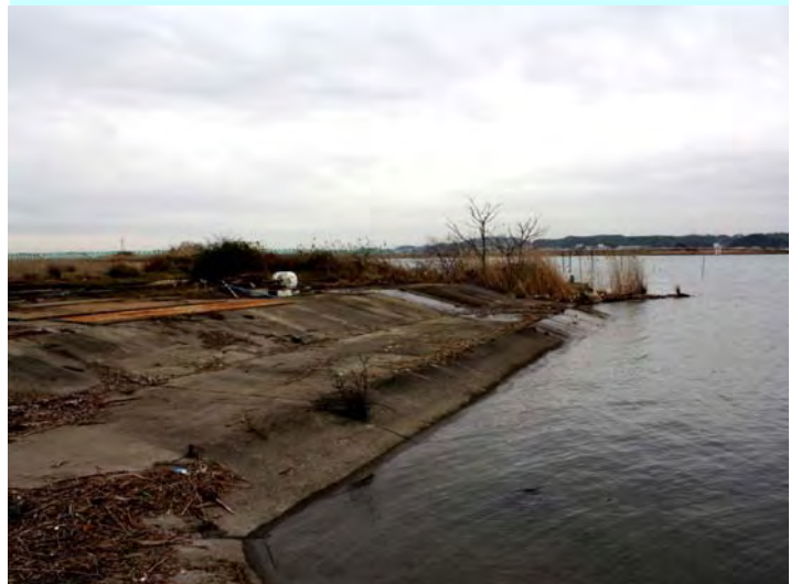
本日の作業後の状況
