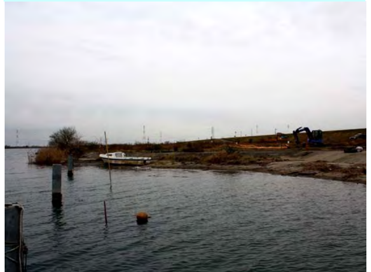
本日の作業後の状況
