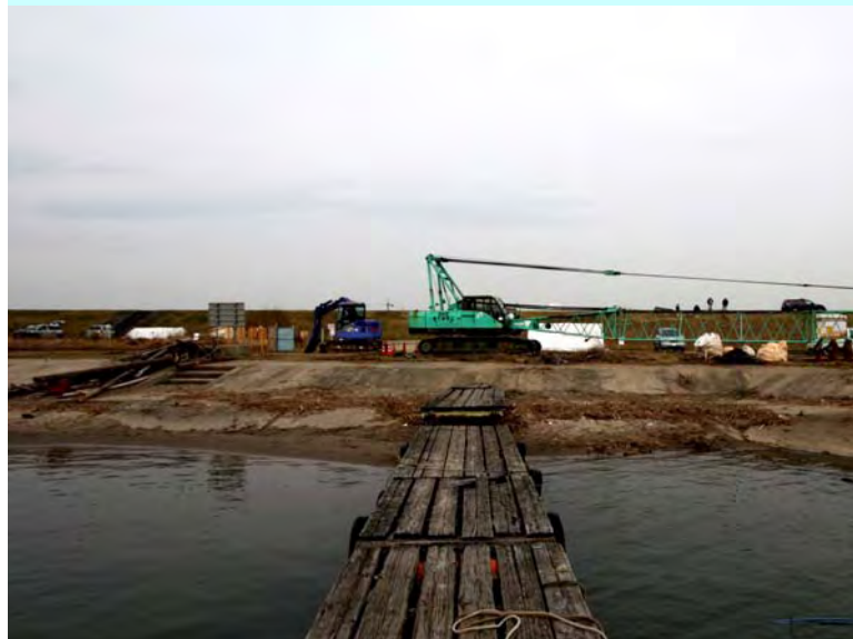
本日の作業後の状況
