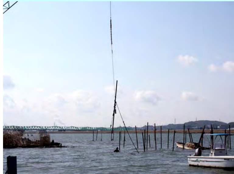
単管パイプの撤去
