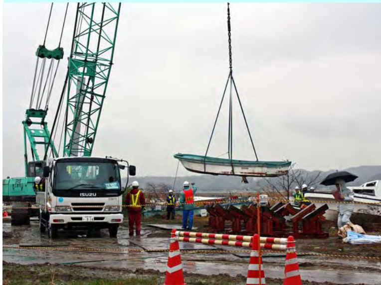
船舶撤去作業の状況
