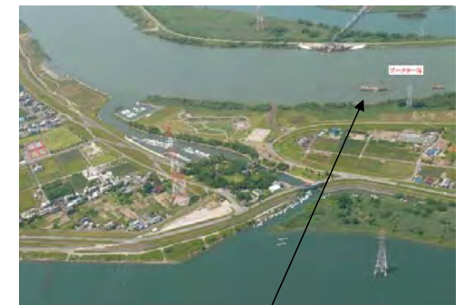
大型作業船位置
