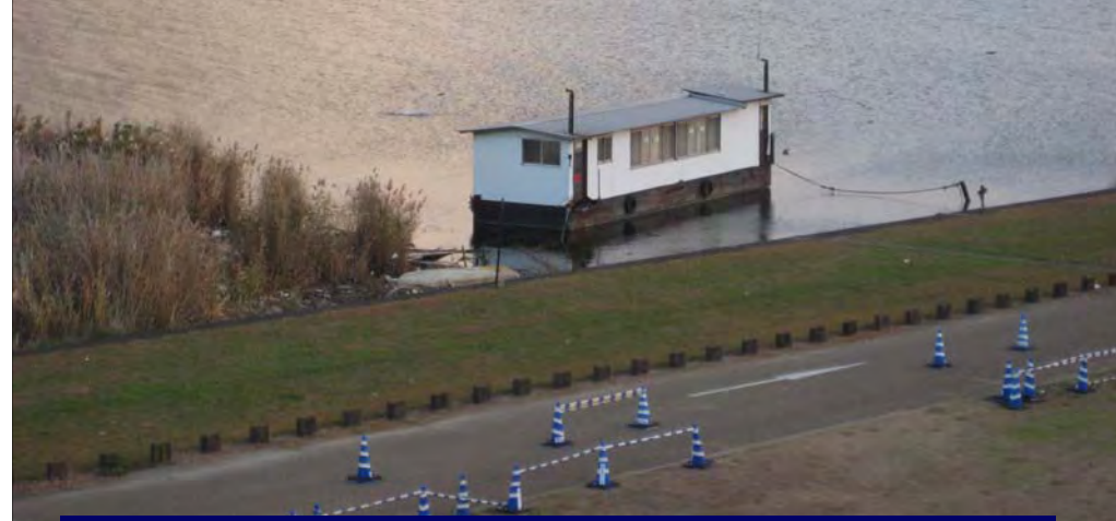
洪水時の流出の危険性が高いため、早期の強制撤去が必要。
