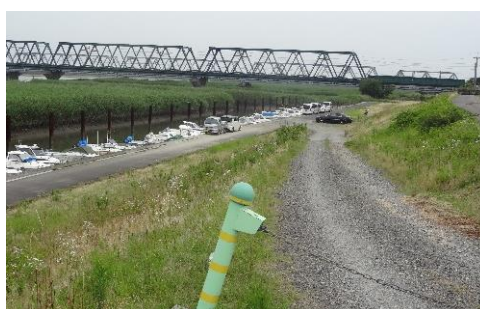
写真4 一時的に係留を認めている施設状況
