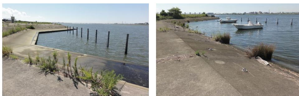
写真3 変形護岸の施設状況
