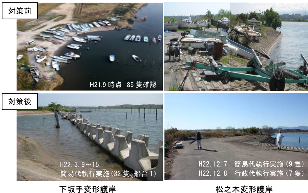
写真2 強制的撤去措置の状況
