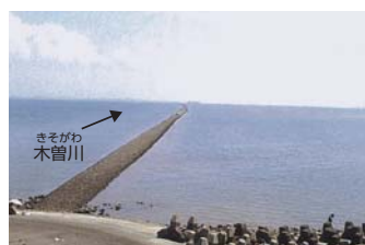
●木曽川の出口につくられた水を導く堤防 (導流堤)
