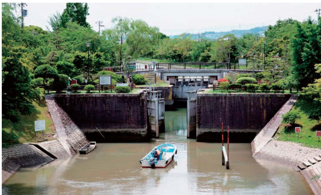
せんだひらこうもん 船頭平閘門
