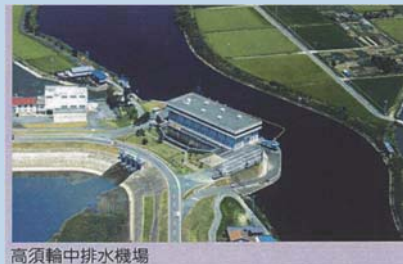
高須輪中排水機場
