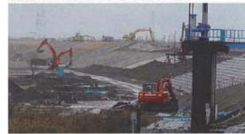
堤防のはばを広げ、高くする工事
