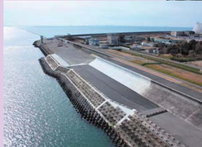
木曽川右岸松蔭地区高潮堤防
