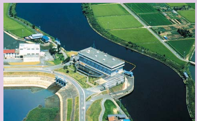
高須輪中排水機場
