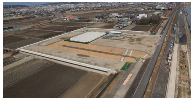
河川防災ステーション(揖斐川右岸城南)
