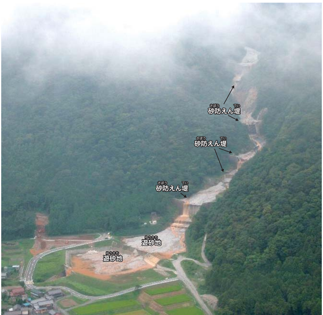
土砂災害から地域を守った砂防えん堤などのようす
