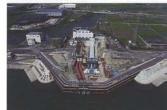
ひ管を頑丈にする工事
