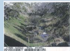
四ツ目川流路工（岐阜県中津川市）
