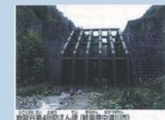
地獄谷第4砂防えん堤（岐阜県中津川市）
