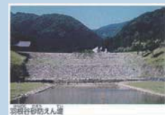
羽根谷砂防えん堤
