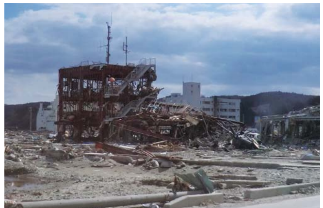
津波によって失われた町（宮城県本吉郡南三陸町）
