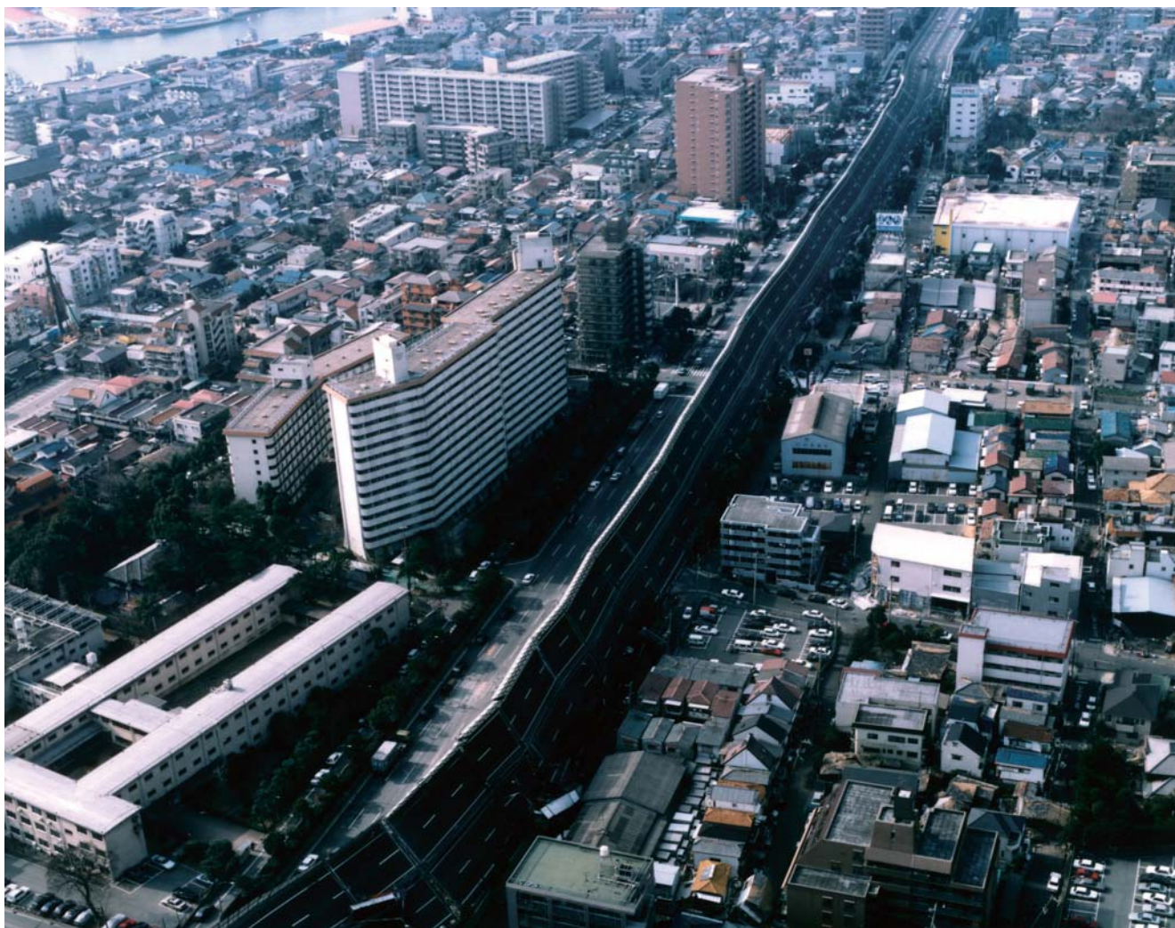
こわれた阪神高速自動車道 (写真提供: 中日本航空 (株))
