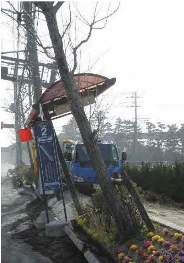
液状化でもりあがった歩道（千葉県浦安市） (写真提供：浦安市)
