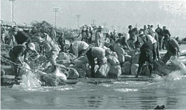
ソダ沈床の沈設作業 (三重県桑名郡長島町白鷺)
