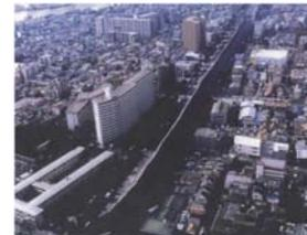
六甲山地の活断層に沿った被害が甚大で、倒壊家屋による圧死者の他、火災182件、地盤の液状化が多数発生。また、予想外であった橋脚、高架の落下や高速道路の倒壊など社会基盤の被害も甚大でした。この震災では6432名の方が犠牲となりました。
