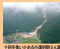
土砂を食い止める小滝砂防えん堤
