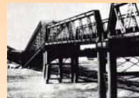
濃尾地震により落ちた鉄橋
