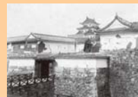
濃尾地震により壁が壊れた名古屋城
