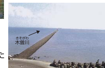
● 木曽川の出口につくられた水を導く堤防 (導流堤)
