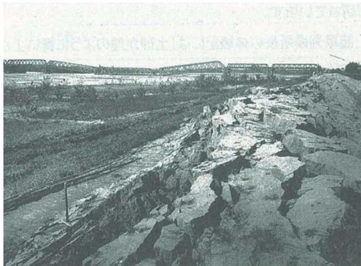
地震によって、地面が水のような状態となり、地面から水が吹き出したり、建物が沈んだり、地盤がこわされたりしました。
