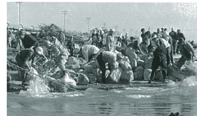
ソダ沈床の沈設作業（三重県桑名郡長島町白鷺） （写真提供：（株）日映映像）
