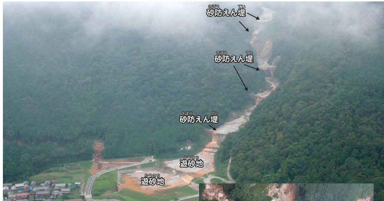
土砂をくい止める小滝砂防えん堤(三重県いなべ市)
