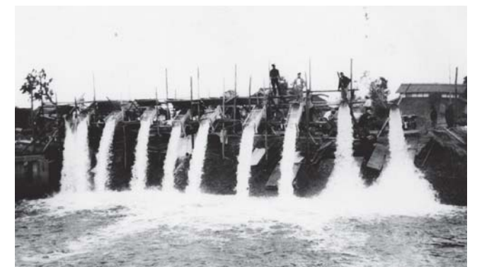
仮設ポンプによる排水作業（三重県桑名郡長島町大島）
