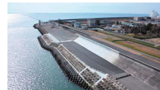
木曽川河口部の高潮堤防
