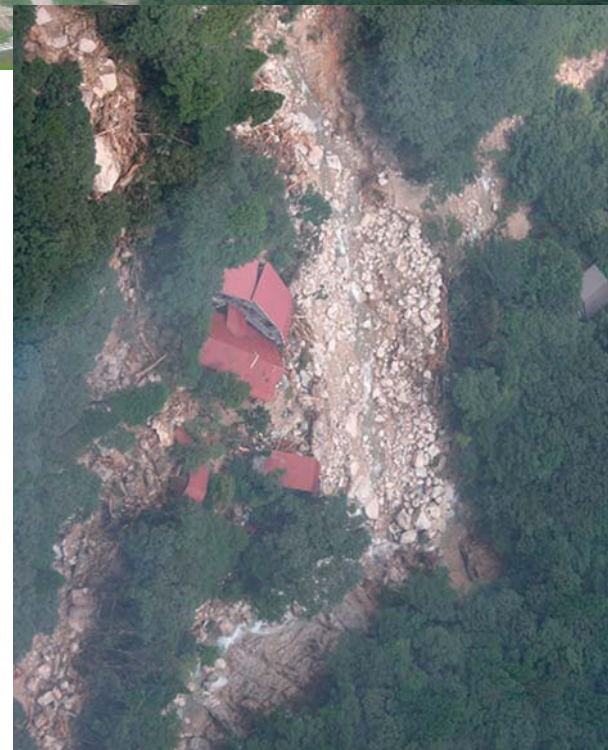
土砂によりつぶれた家(三重県菰野町)
