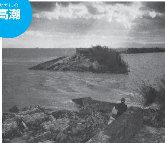
決壊した長島海岸堤防 (三重県桑名郡長島町)
