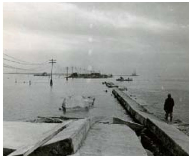
こわれた長島町の損斐川堤防（三重県）
