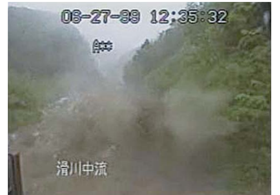
滑川第1砂防堰堤(上松町)により止められた土石流 (多治見砂防国道事務所土石流CCVTカメラ撮影映像より)
