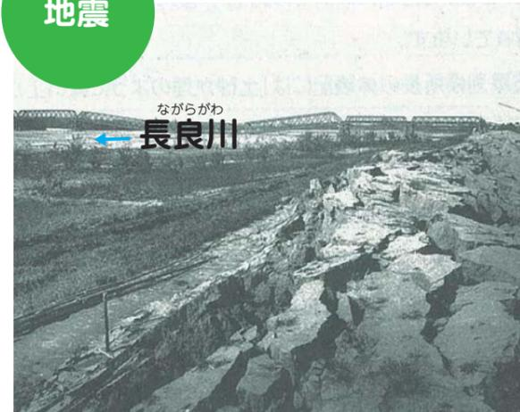
明治 22 年濃尾地震により壊れた長良川の堤防と鉄橋
