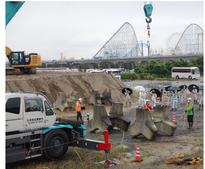
オートフックによるコンクリートブロック投入訓練
