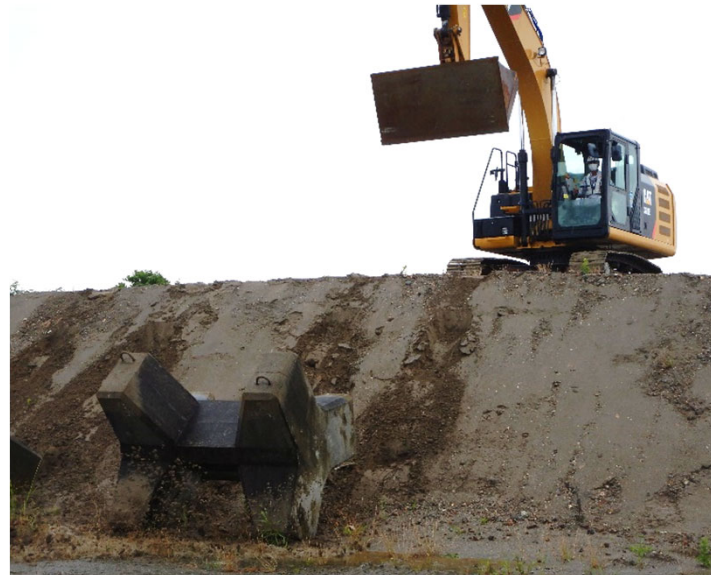
BHによるコンクリートブロック投入訓練
