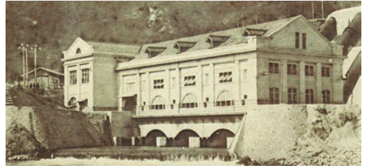
賤母発電所外観＜出典：『賤母水力』＞
