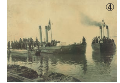
図8 淀川改良工事に使用された機械 ①掘削機械（図2の機械の反対面） ②軽便軌条（レール）（常吉突堤工事個所） ③バケットラダー式浚渫船 ④曳船＜淀川河川事務所蔵＞
