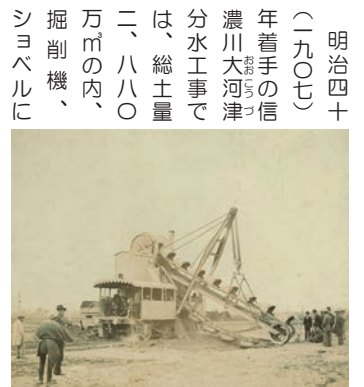
図2 淀川改良工事に使用した掘削機 (ラダーエクスキャベータ) 〈淀川河川事務所蔵〉
