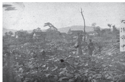
写真2 濃尾地震後の大垣(出典：岐阜県図書館所蔵資料を加工(「災害アーカイブ」ホームページ提供) >
