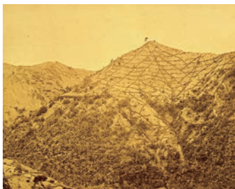
綺田山の「葺網工」<出典：木曾川文庫所蔵「エッシャー家文書」より>
