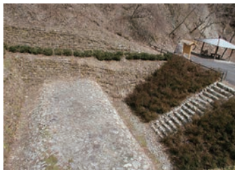
大崖砂防堰堤 高さ5m、長さ50m。大崖砂防公園として整備、公開されている
