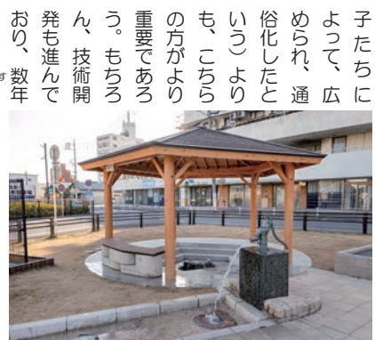
写真5 「水都大垣 清水の井戸」 災害時に生活用水として活用できるように手押しポンプを設置大垣市提供
