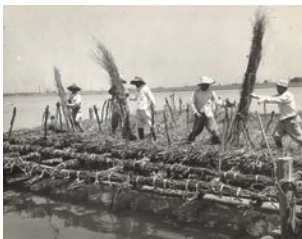
淀川での粗朶水制工の作業状況（昭和32年、十三大橋付近） ＜淀川河川事務所所蔵＞
