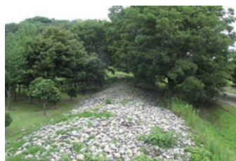
岐阜県各務原浄化センターの敷地内にある前渡猿尾 長さは、寛永7(1630)年の国役普請で64間半(約117m)。明治4(1871)年の図からは、長さ182m、高さ4.4m。現在は286mである。
