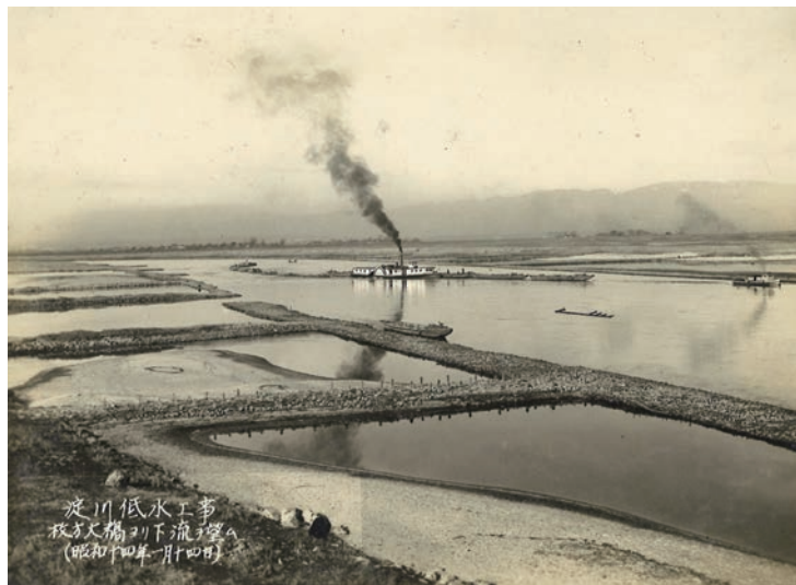
淀川に設置された粗朶水制(ケレップ水制、手前)と遡行する蒸気船(枚方大橋より下流方向を望む。昭和14年)＜淀川河川事務所蔵＞
