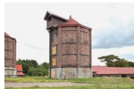
写真2 第一号サイロ（明治40年建造） サイロは、牧草などを発酵させるための施設。煉瓦造・日本の現存最古のサイロ。 ＜写真提供：同上＞
