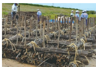
作成中の粗朶沈床 ＜提供：信濃川下流河川事務所＞
