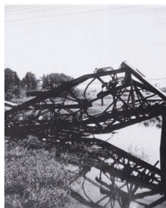
写真⑩ 爆弾で破壊された近鉄損斐川橋梁＜出典：『伊勢電・近鉄の80年』＞
