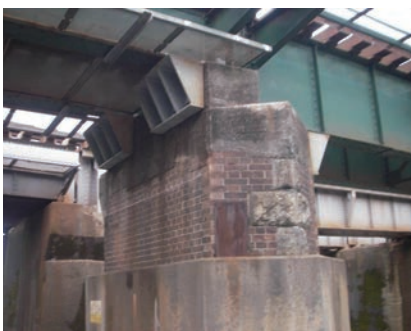
写真② 明治27年に関西鉄道が開通した当時の播磨川橋梁は補修され乍も現役として活躍。現在のJR関西本線桑名駅と揖斐川橋梁の間にある、大山田川に架かる橋梁。
