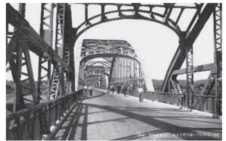
写真⑤ 完成した伊勢大橋<個人提供>
