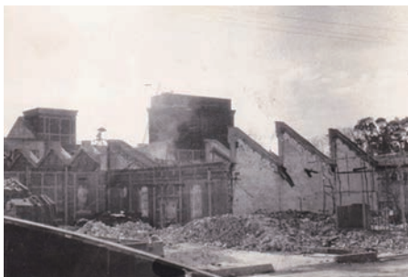
写真⑦ 被災した元東洋紡績桑名工場 <小林カメラ撮影>
