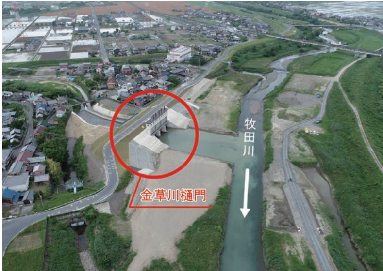
現在、改修工事が行われている金草川樋門① 〈提供：木曾川上流河川事務所〉
