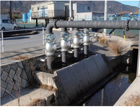
新設された水中ポンプ(提供: 養老町役場)
