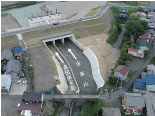
現在、改修工事が行われている金草川樋門② (提供: 木曾川上流河川事務所)
