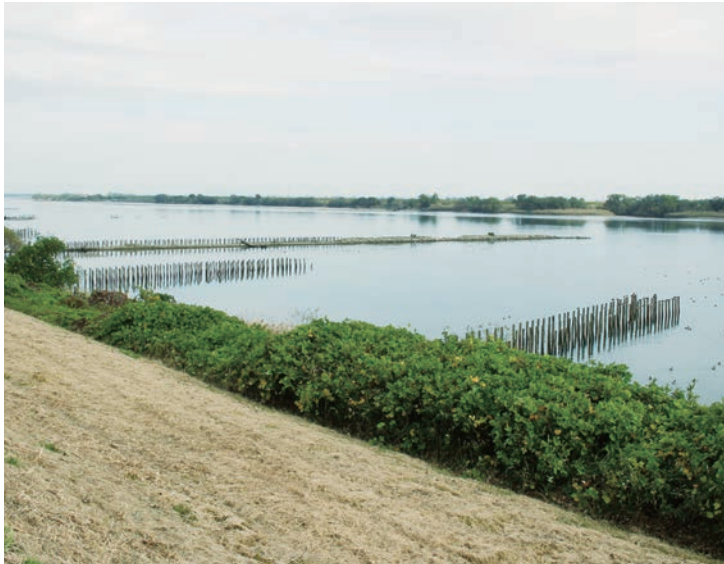
ケレップ水制と杭出水制の組み合わせが生み出す景観
