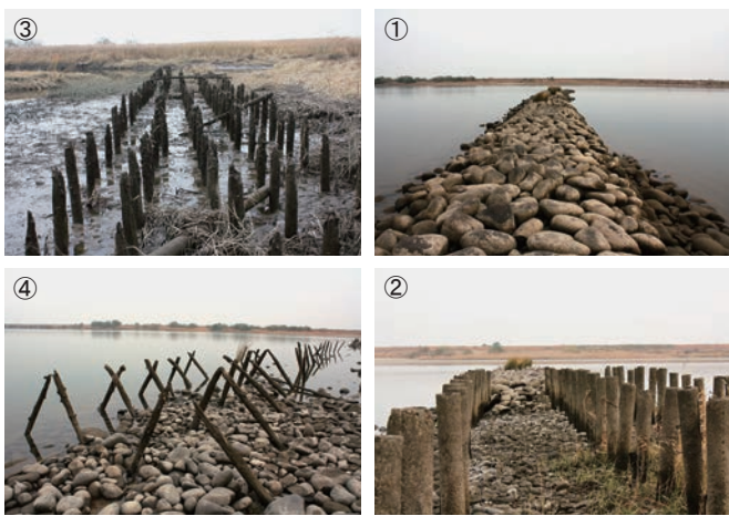
図1 木曾川の水制の種類 〈出典：木曾川下流河川事務所「木曾川の水制」〉
