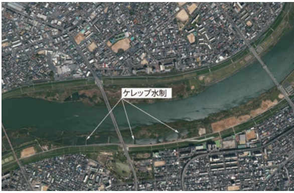
図3 淀川（城北地区）の水制群 〈出典：国土地理院撮影の空中写真（2017年4月14日撮影）を加工して作成〉
