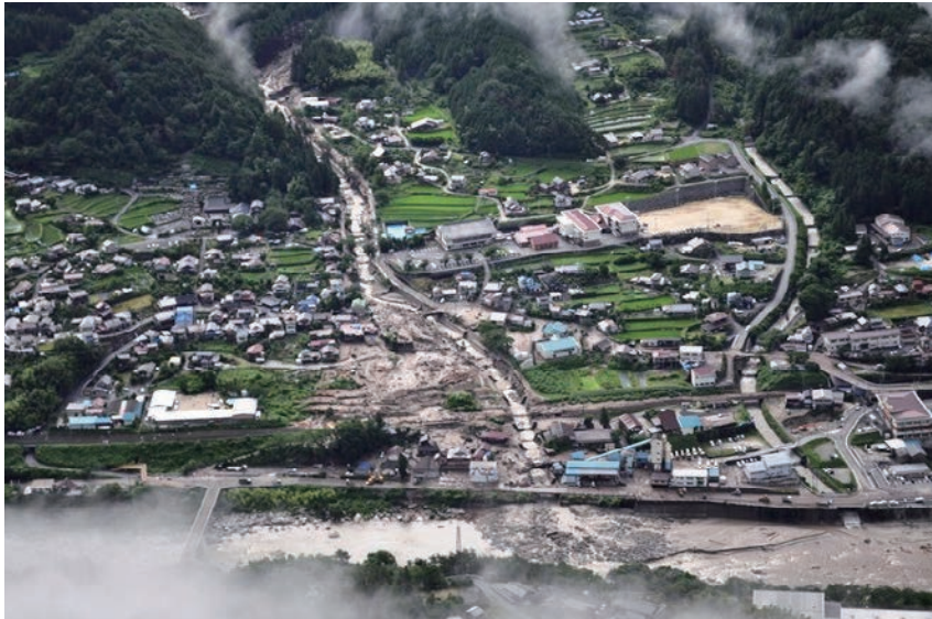
平成の蛇抜け（梨子沢土石流災害）の発生状況 〈提供：多治見砂防国道事務所〉
