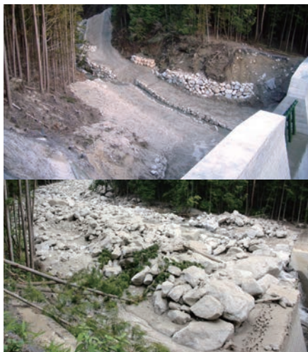
梨子沢第2砂防堰堤の砂防効果 上：災害発生前(2014/03) 下：災害発生後(2014/07/12) 提供：多治見砂防国道事務所
