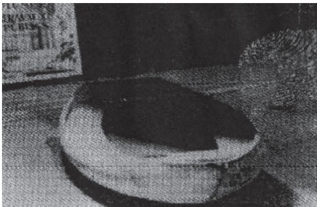
ランボーが1855年パリ万国博覧会に出した金網を入れたポート 〈出典：「欧州における鉄筋コンクリート技術の歴史の変遷」〉
