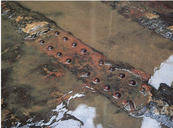
船頭平閘門の門柱の底盤（閘頭部）に埋め込まれた鋼桁 〈出典：『船頭平閘門改築記念誌』〉
