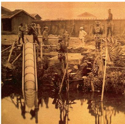
エッセル家に保管されていた踏車とアルキメデス・スクリューでの排水試験
