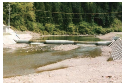
平成7年3月に完成した鬼谷川のファブリ ダム 〈提供：郡上市和良振興事務所〉
