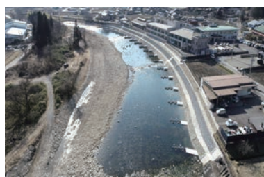
復旧した和良川被災地の護岸工 (提供：郡上市和良振興事務所)
