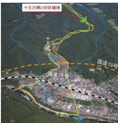
十王沢第二砂防堰堤の改築 〈提供：多治見砂防国道事務所〉
