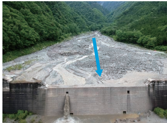
令和2年6月14日、約50,000㎡の土砂を捕捉した滑川第一砂防堰堤 〈提供：多治見砂防国道事務所〉
