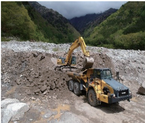
滑川第一砂防堰堤での除石作業の様子 〈提供：多治見砂防国道事務所〉
