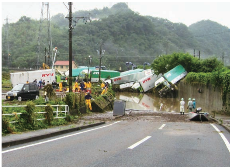
土田地区アンダーパス付近の被災状況 〈提供：可児市役所防災安全課〉
