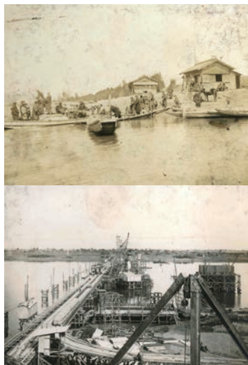
上：揖斐川堤防の渡船場 下：伊勢大橋橋脚工事 〈出典：桑名市立中央図書館蔵〉
