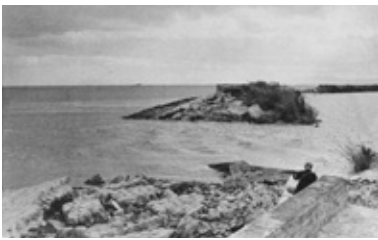
■ 長島海岸堤防の破壊状況
