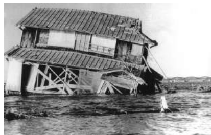
■ 倒壊寸前の民家(桑名市長島町殿名)
