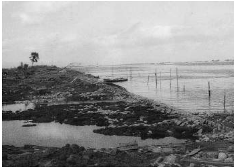
■ 木曾川堤の破堤状況(伊勢湾台風30年記念誌写真提供)
