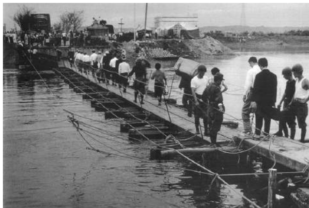
■ 国道1号長栄橋が流失したため、自衛隊によって架橋されたベリール橋
