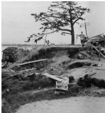
■ 堤防もろとも崩れ落ちる家屋 (伊勢湾台風30年記念誌写真提供)
