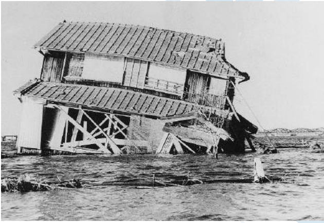
■ 倒壊寸前の民家(殿名地区)
