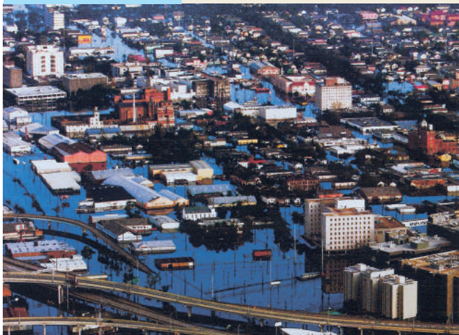
■カトリーナにおける浸水被害
