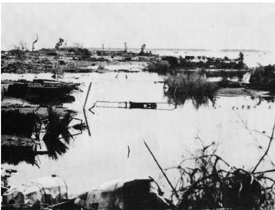
■ 木曾川堤沿いを望む 50戸余全部流失の跡(松東地区)
