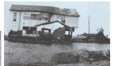
■ 木曾川左岸堤防の破堤 木曾岬町白鷺
