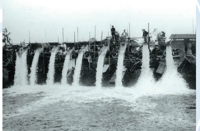
■ 仮設ポンプによる排水作業 (桑名市長島町松蔭)
