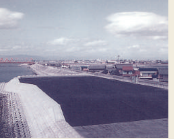
平成2年度木曾川源緑高潮堤防補強工事
