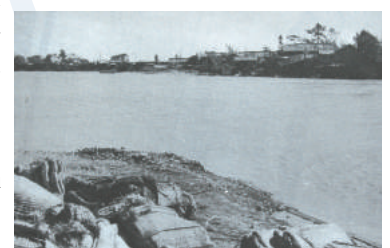
■岐阜市芥見の破堤状況
