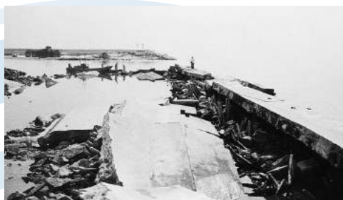
■ 損斐川左岸白鷺附近
