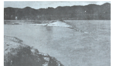
■岐阜市芥見の破堤状況
