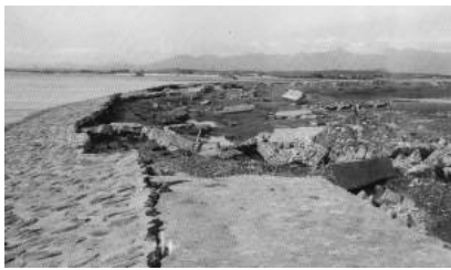
■ 根こそぎ破壊された海岸堤 (伊勢湾台風30年記念誌写真提供)
