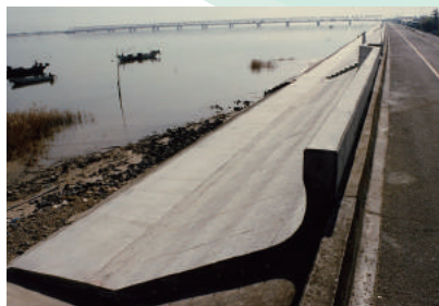
■パラベットの完成部分(昭和54年)
