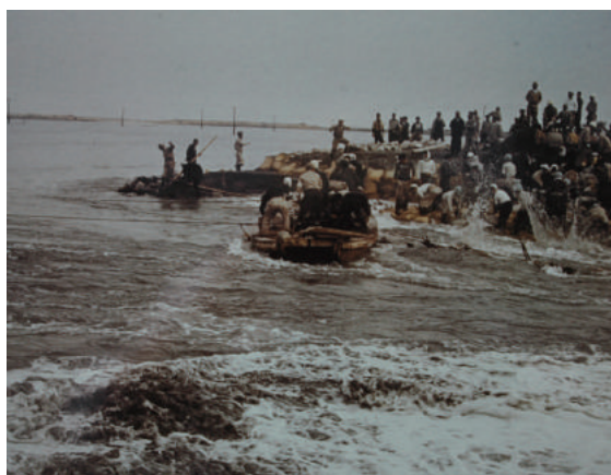
■ 揖斐川左岸白鷄地先の仮締め切り状況②
