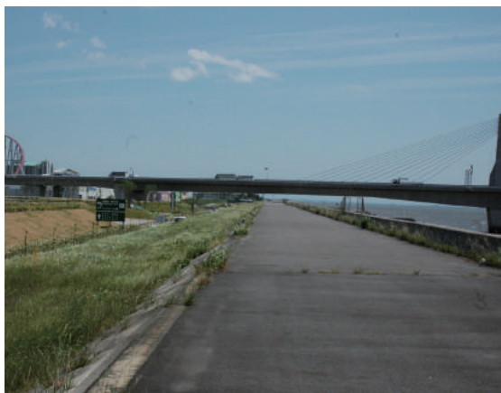
■ 揖斐川左岸白鷄地先の最終締め切り地点付近の現況
