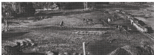
■ 牧田川根古地の復旧状況
