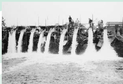
■ 仮設ポンプによる排水作業
