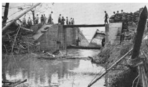
■ 破壊された三の丸樋門
