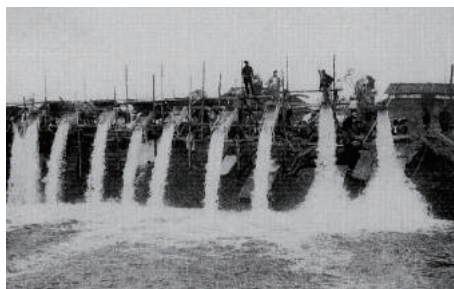
■ 仮設ポンプによる排水作業
