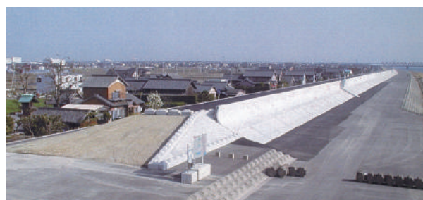
■高潮堤防補強工の完成区間
