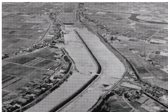
■ 復旧後の鍋田川の中央部付近(左側木曽岬村、右側弥富町)
