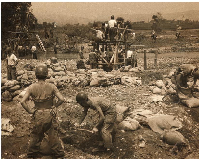
昭和34年8月の集中豪雨の復旧工事
