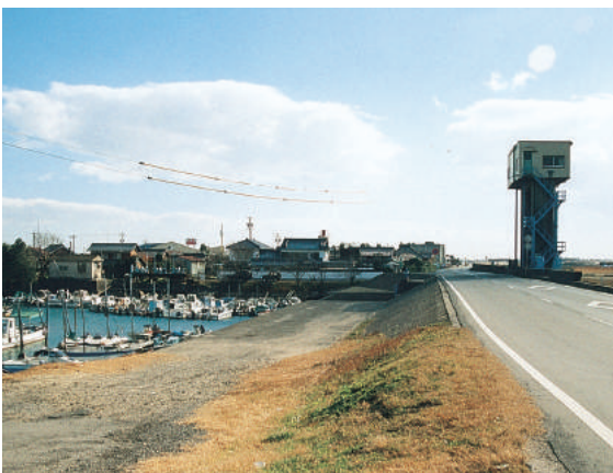
■ 木曾川左岸鍋田川上水門(元鍋田川分派点)
