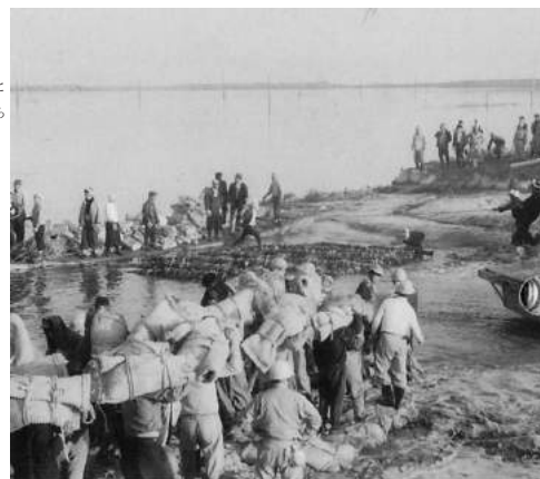
■伊曾島仮締め切り
