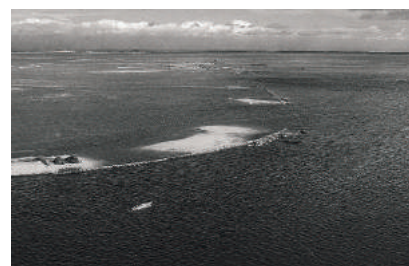
鍋田干拓堤防災害風景
