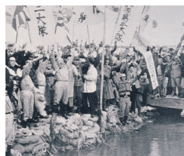
応急仮締め切り竣工式風景
