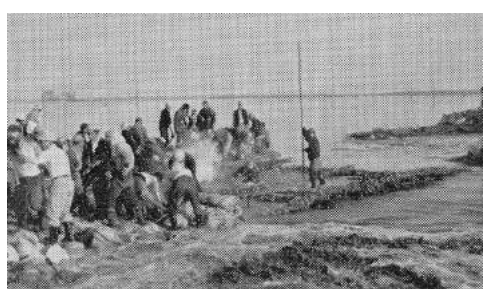
■ 揖斐川左岸白鷄地先の仮締め切り状況①
