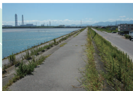
■城南海岸堤防の現況
