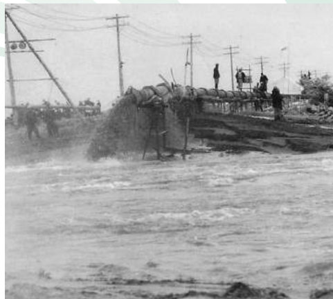
■ 木曾川左岸雁ヶ池付近締め切り工事
