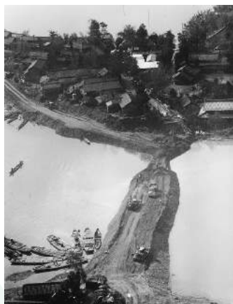
■ 決壊後の復旧工事
