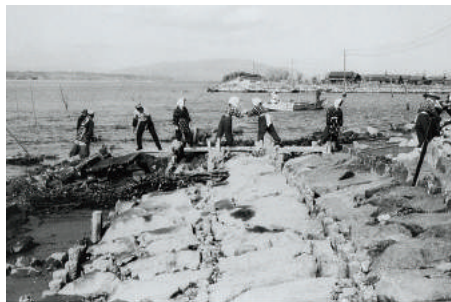
■ 締め切り口まで手渡しで運ぶ土のう(長島町白鷺)
