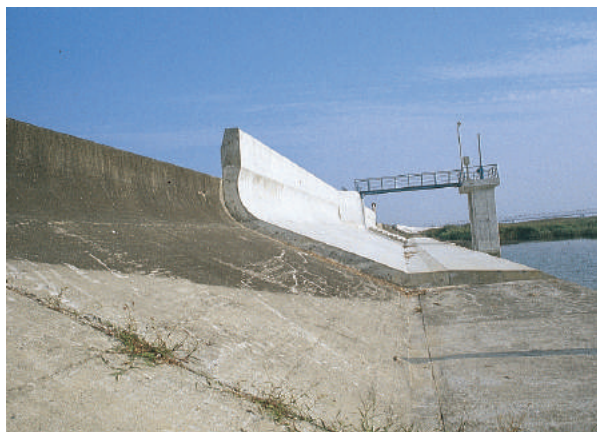
■ パラペット緊急嵩上げ工事
