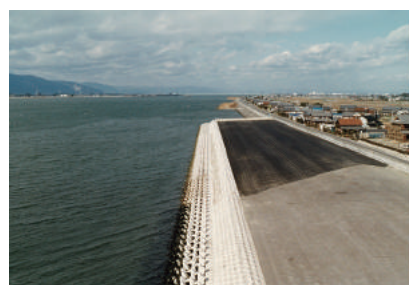
■前小段補強の完成状況
