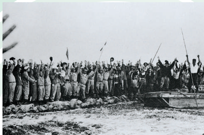
■ 最後の仮締め切り工事完了(長島町白鷺)
