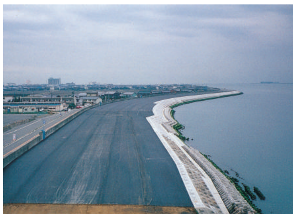
■ 損斐川左岸高潮堤（前小段造成）
